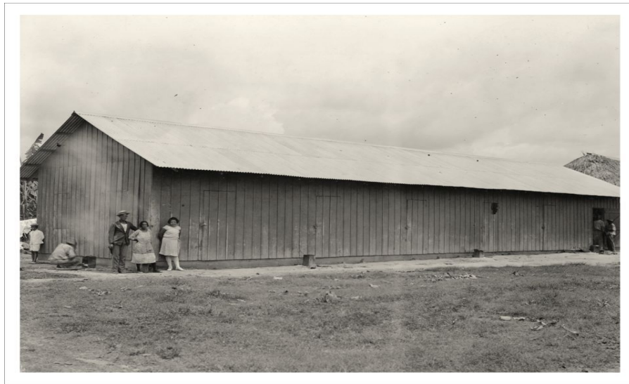
Figura 2. Campamento de labores Indiana en las plantaciones bananeras del Magdalena
