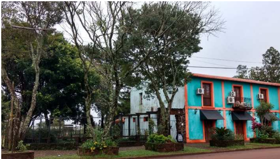
Figura 4. Hostería Don Francisco; rocas reutilizadas con juntas de cemento y realización de canteros
