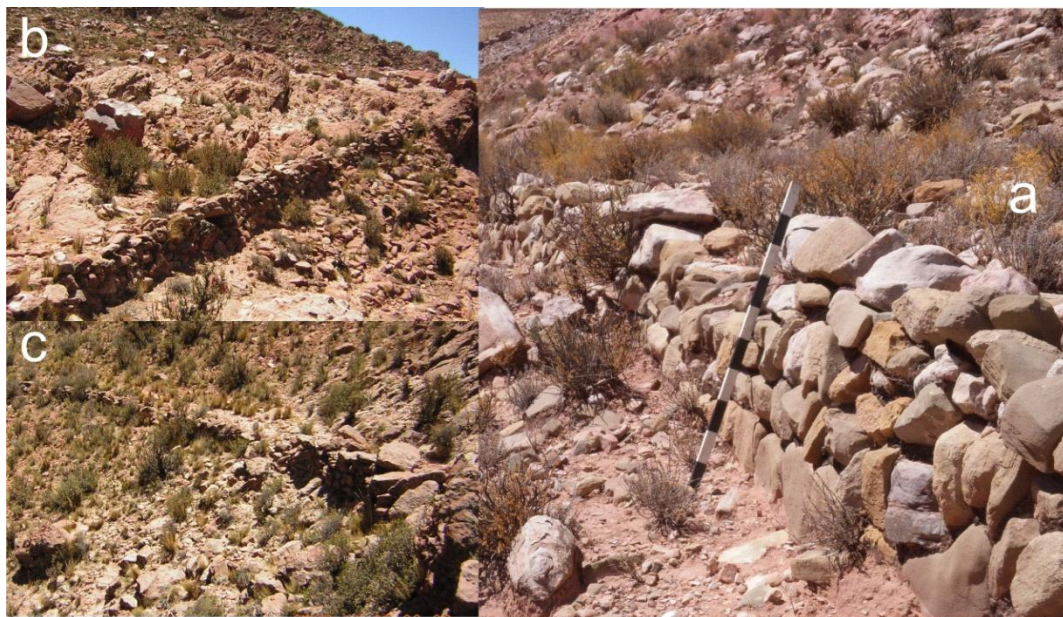
Figura 3: Tramo de camino inka que ingresa a la quebrada de Inca Cueva desde la puna de Jujuy. a- Con muro de retención lateral. b- En pendiente, cavado sobre la roca madre y con muro de retención lateral. c- Con muro de retención lateral, en pendiente ondulada.
