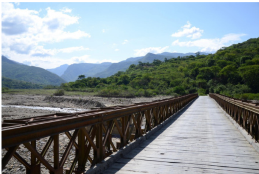
Figura 8. Puente Bailey actualmente en uso.
