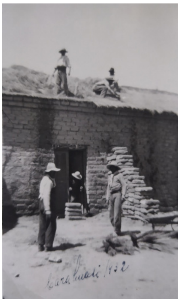
Figura 1: Retechado ( guayado ) del edificio de la Escuela N° 22 de Carahuasi.
