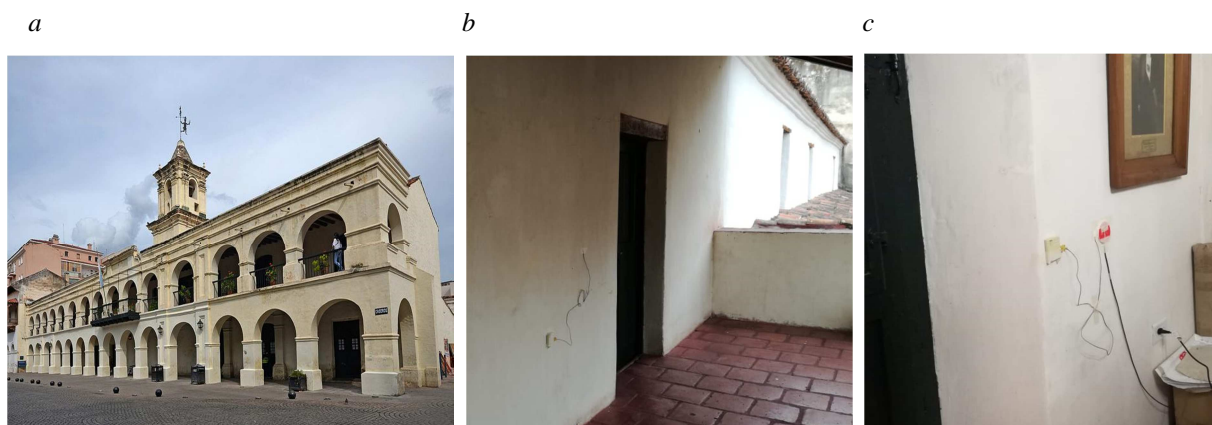
Figura 1: a) Cabildo de Salta, vista de la fachada norte. Muro sensado, b) lado externo y c) lado interno.
