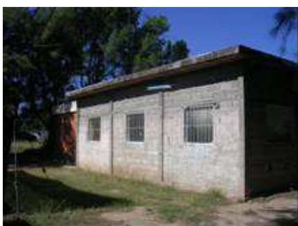
Foto 3.- Ventanas de la sala de lavado orientadas hacia el Norte.
