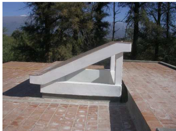
Foto 2.- Terminación techo modificado
