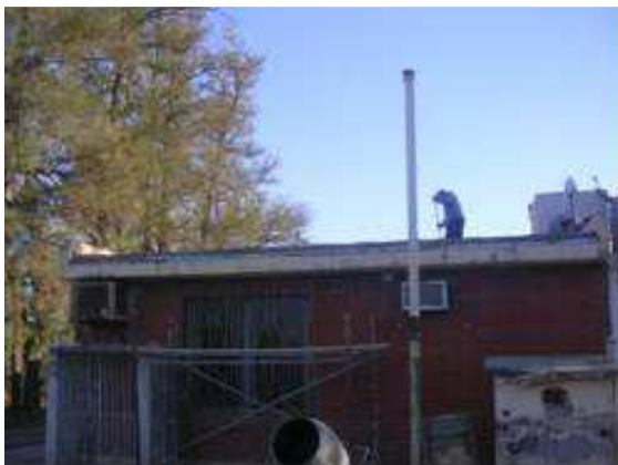
Foto 1.- Construcción techo con aislación
