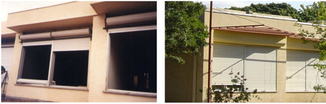
Figura 6 Ventanas en fachada norte para mostrar el detalle del tapa-rollo externo y su cobertura (se repite en la carpintería del muro sur)
