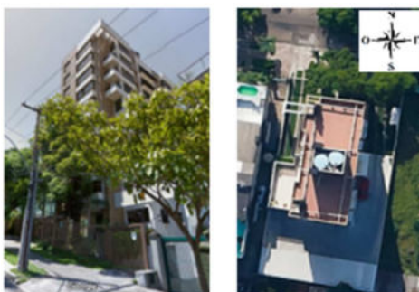
Figura 2: (a) Edificação alvo do estudo e (b) vista superior do local de instalação dos sistemas FV.
