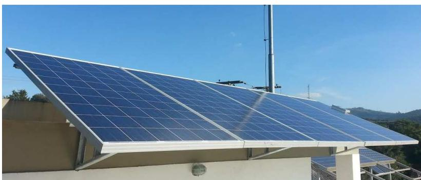
*Figura 1: Arranjo instalado com 20 graus de inclinação.*
