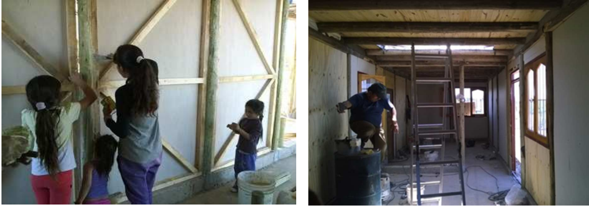
Figura 5: vista interior izq. Sellando juntas y terminando sobredinteles.
