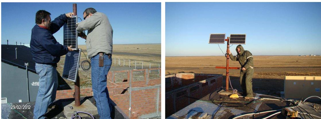
*Figura 1: Montaje de paneles en techo Lab. AEA (izq) – Reinstalación con nuevo soporte (der)*
