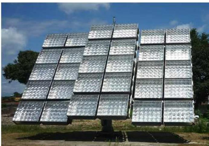
Figura 1. Gerador HCPV instalado no Departamento de Energia Nuclear-UFPE.
