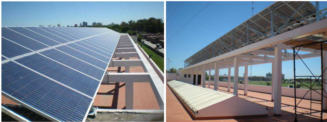
Figura 11: Pérgola FV de 17 kW p en la Facultad de Informática de la UNLP.
