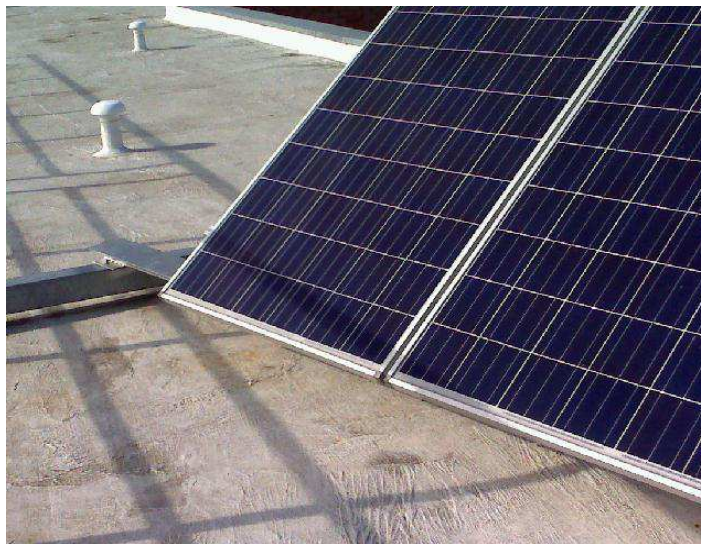
Figura 2: Sombreado parcial de los paneles solares producido por la baranda durante la mañana (aproximadamente 10 hs) del 14 de mayo de 2014.
