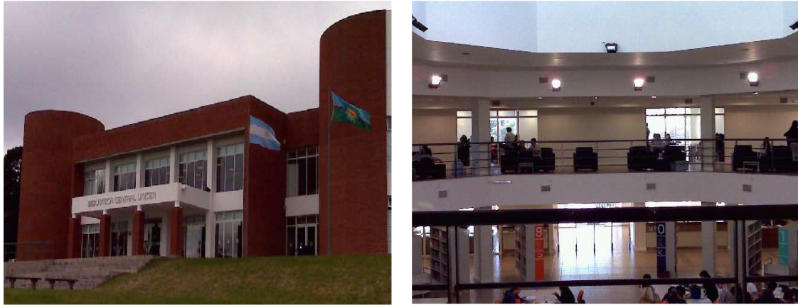
Figura 1: Vistas de (a) la fachada y (b) el atrio central en el interior del edificio de la Biblioteca Central de la UNCPBA.
