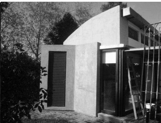
Figura 7: Cara noreste de la vivienda con EIFS.
