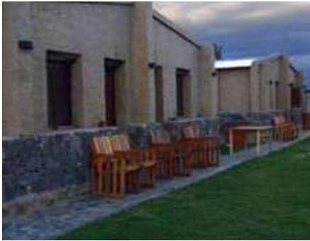
Figura 2: Foto del frente de las cabañas.
