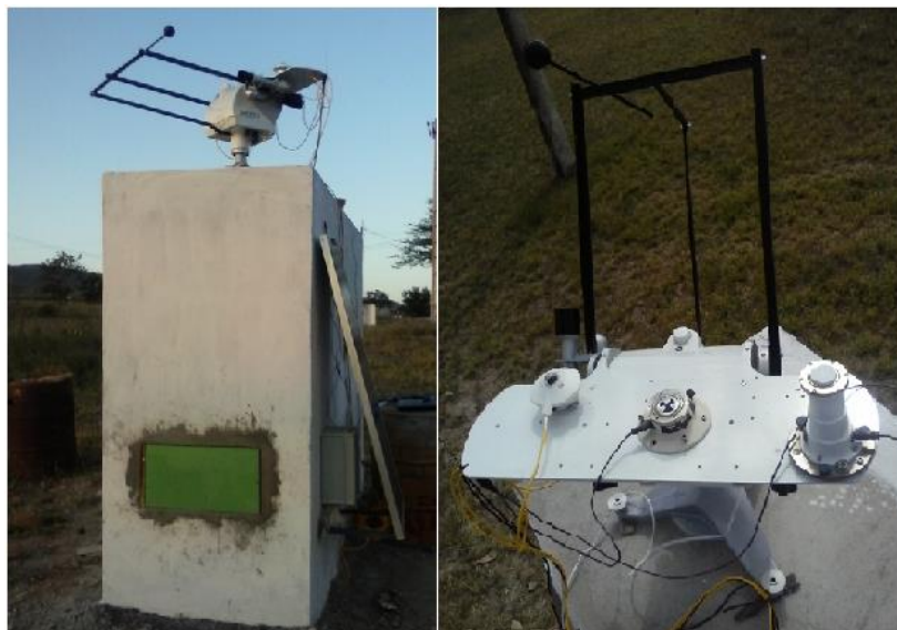
Figura 3: Estação solarimétrica do IFPE Campus Pesqueira. Fonte: Elaborada pela autora.
