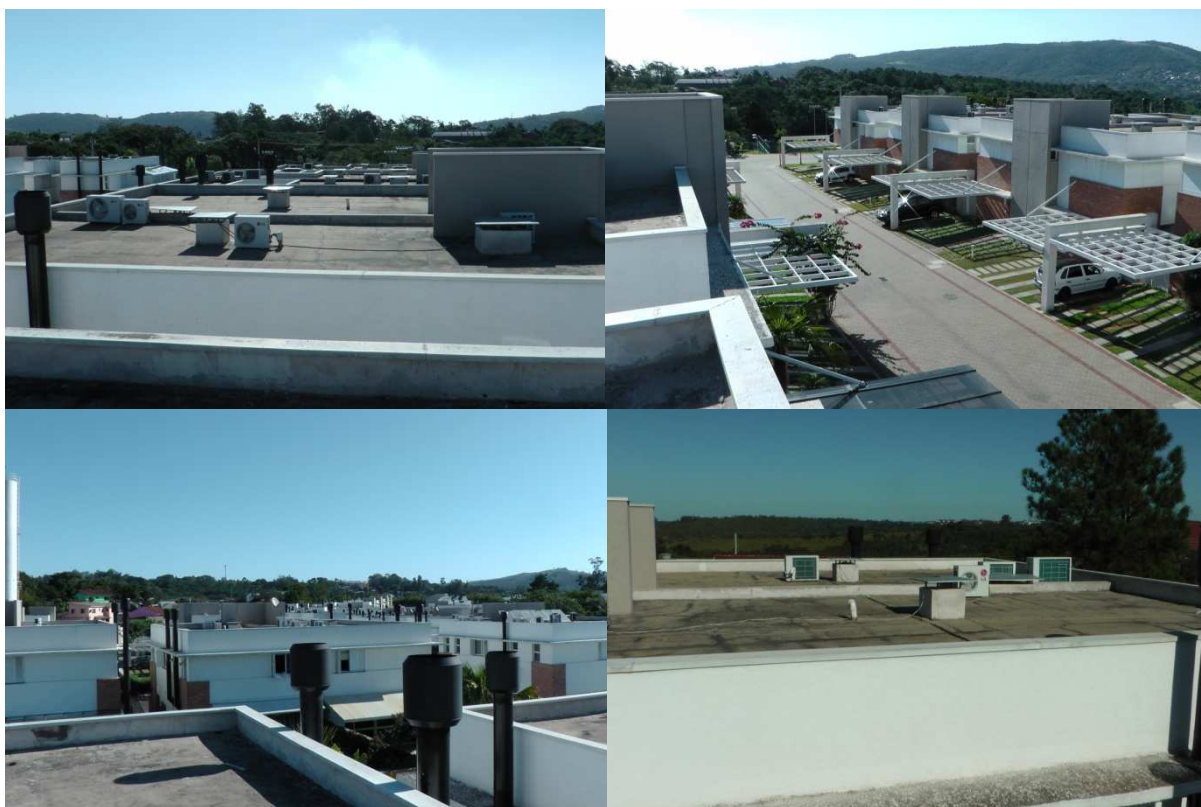
Figura 4: Características do local de instalação dos telhados fotovoltaicos.
