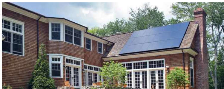
Figura 1: Exemplo de instalação fotovoltaica residencial. (Disponível em: http://us.sunpowercorp.com/ )
