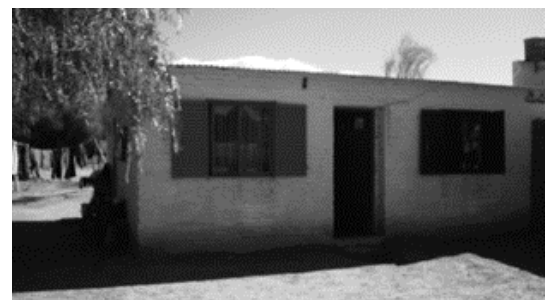
Figura 10: Fachada principal de la vivienda.
