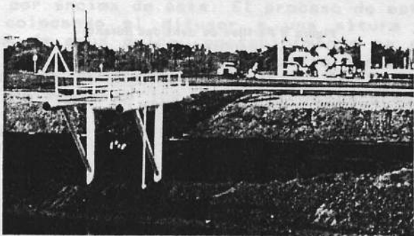
Figura 2 Estanque solar reconstruido
