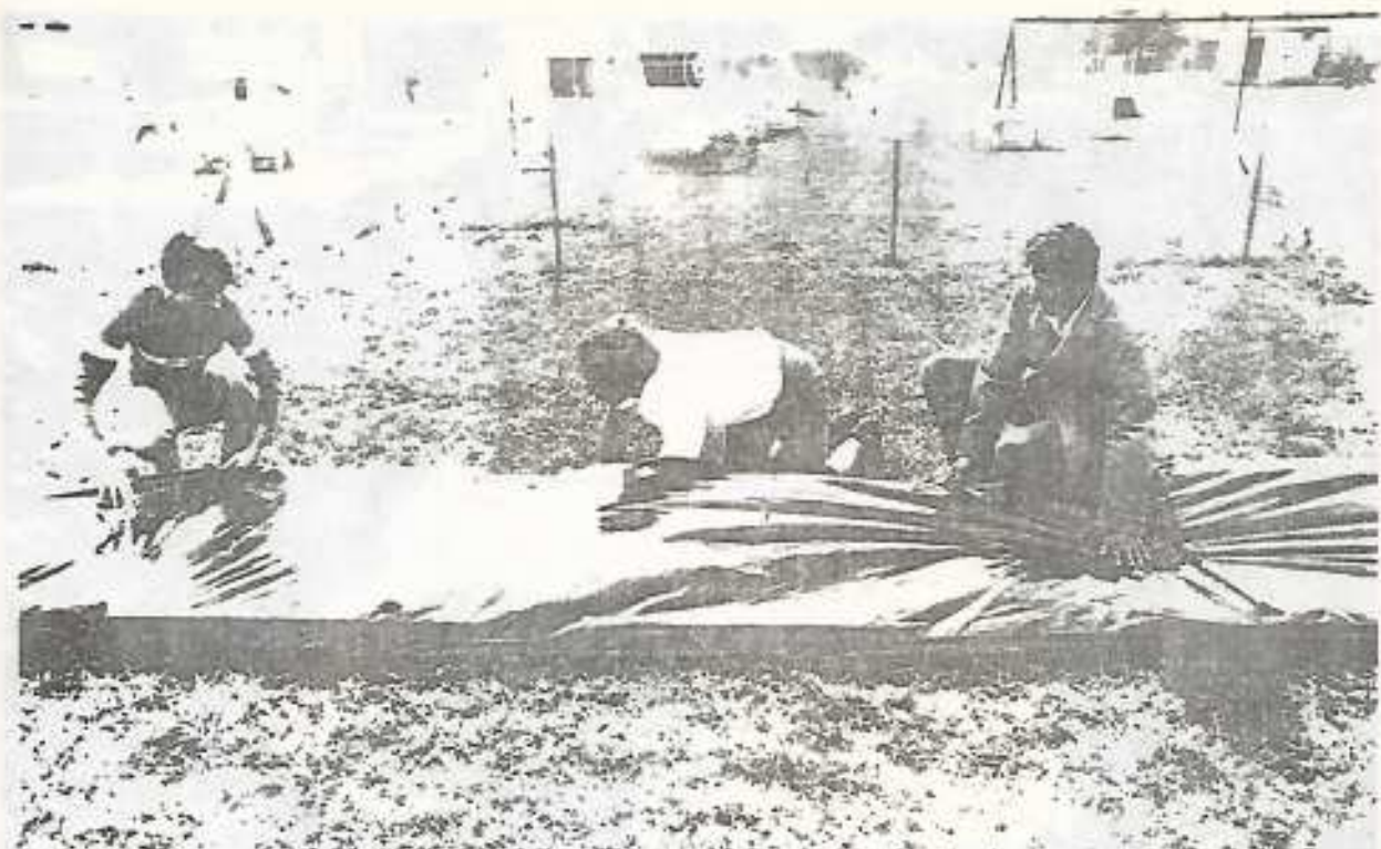
FIGURA 5 - LAS PLANCHAS DE AISLACION SE DESLIZAN ENTRE LAS DOS CAPAS PLAS- INFERIORES A MODO DE ALMOHADA DENTRO DE SU FUNDA.
