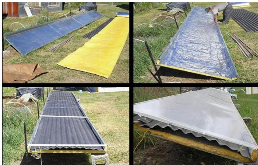
Figura 1: Etapas de construcción del colector prototipo. Fuente (Duran y Condorí, 2013).
