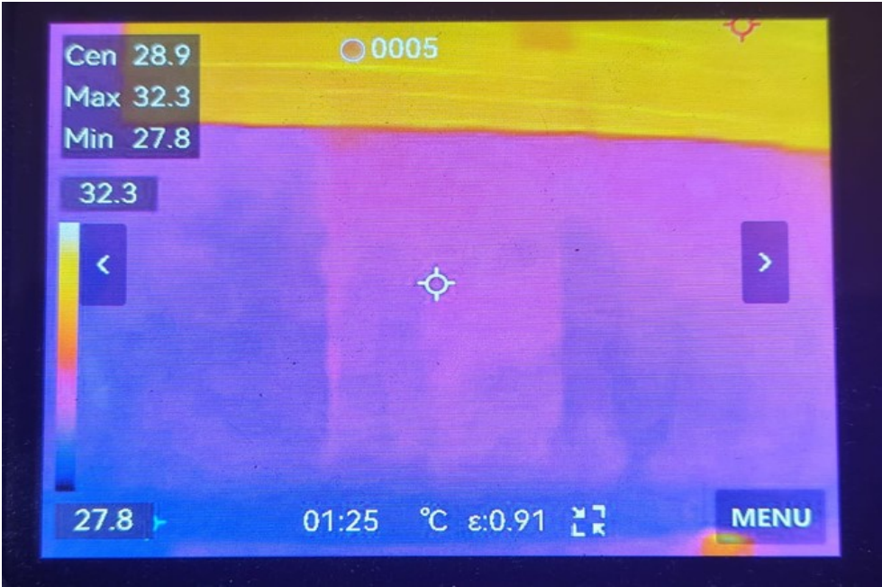
Figura 6. Imagen termográfica tomada in situ. Elaboracion Propia.
