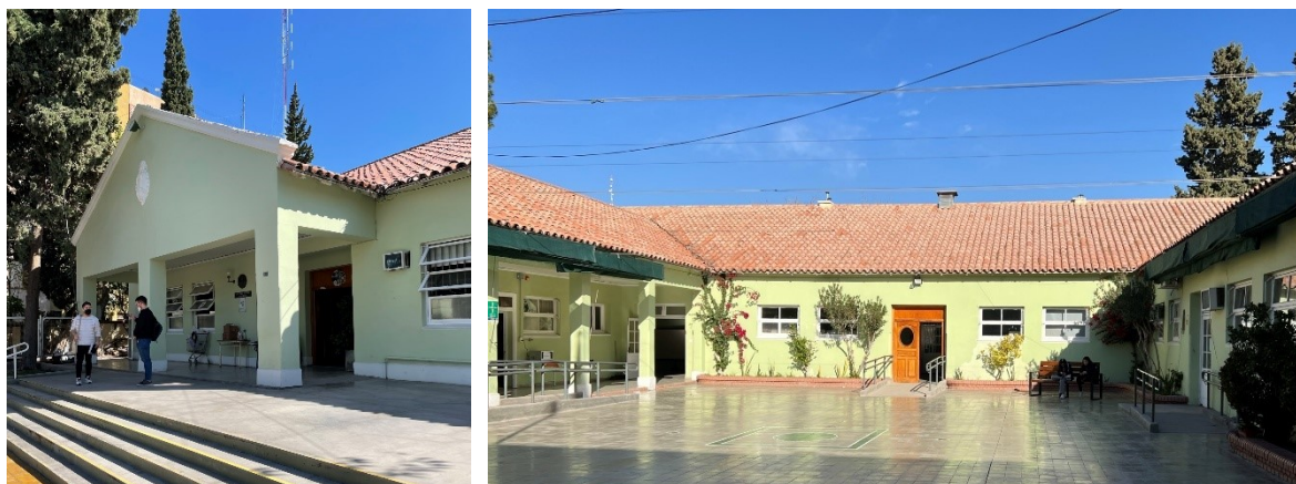
Figura 1: Colegio Central Universitario Mariano Moreno. Fotografías del frente del edificio (orientación sur) y del patio central (orientación norte). Fuente: Elaboración propia.
