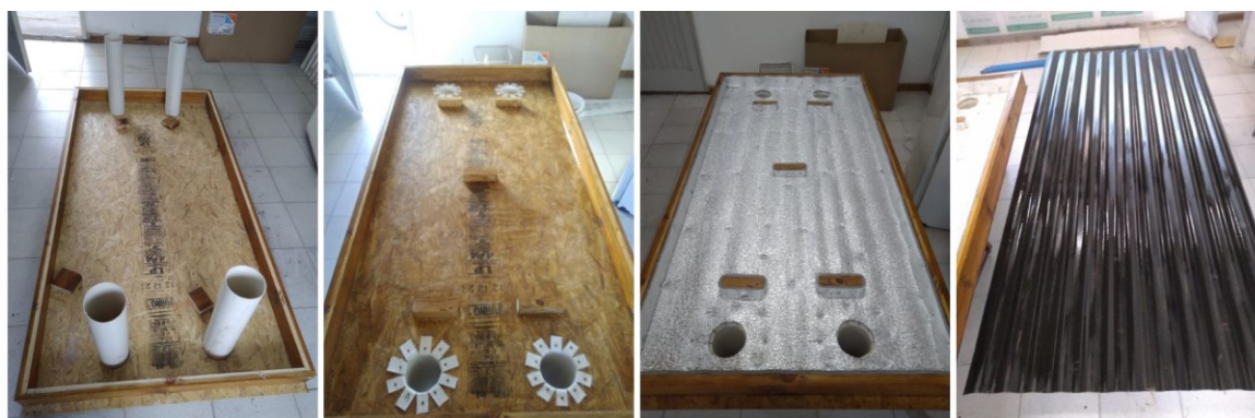
Figura 1: Fotografías durante el proceso de construcción del panel.
