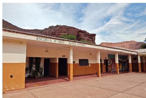
Figura 2: Escuela Rural de Santa Bárbara. Fuente: banco propio de imágenes.
