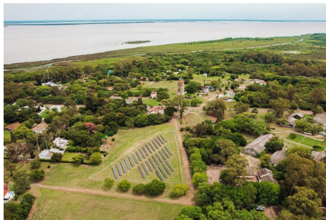
Figura 1: Planta solar fotovoltaica PROINGED en la Isla Martín García (PROINGED, 2025).
