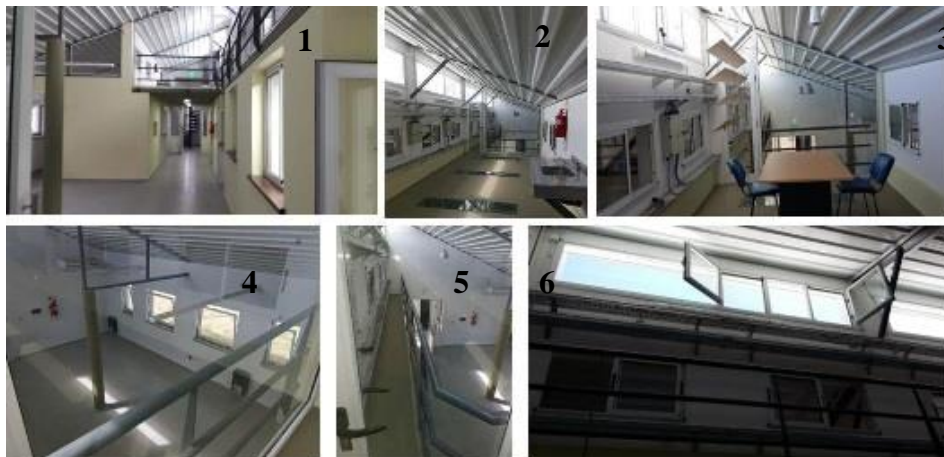
Fig. 3: 1-2 plenum técnico (sector amarillo en corte figura 2), 3 = estantes de luz regulables 4,5 = pasarelas que facilitan la apertura de ventanas para ventilación natural cruzada (6).
