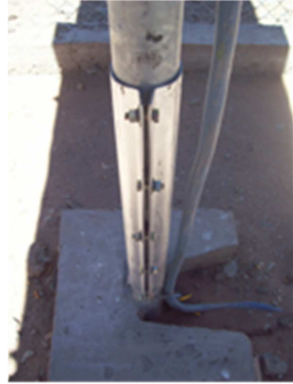
Fig. 8: Reparación de columnas de estructura soporte de módulos FV mediante hormigonado.
