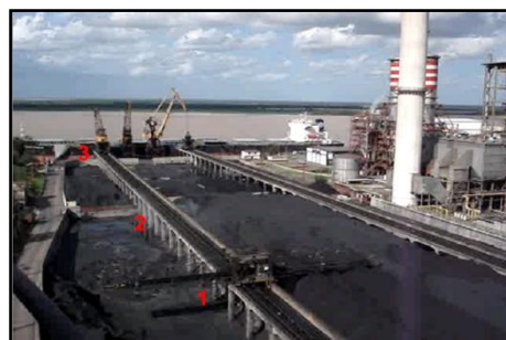
Fig. 1: Vista general de la playa de descarga de carbón. En la imagen se detallan: 1) Cinta móvil llamada avión, encargada de descargar el carbón en la playa; 2) Cinta fija encargada del transporte del carbón desde la tolva a los aviones y 3) Tolva, donde las grúas depositan el material, el cual es descargado en la cinta fija.
