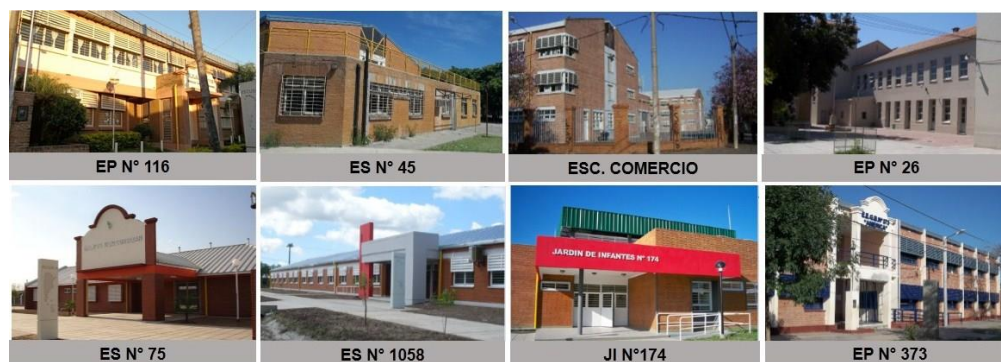
Fig. 1: Edificios escolares auditados en la ciudad de Resistencia, Chaco.
