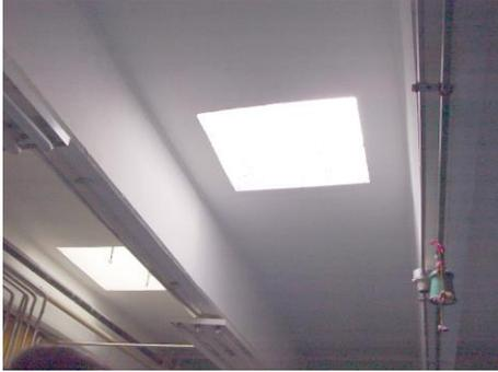
Fig. 2: Vista interior de los lucernarios ubicados entre las vigas del edificio.
