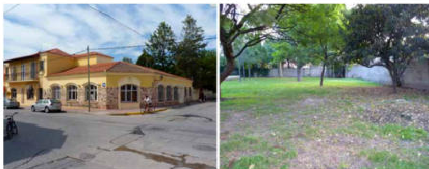
Figura 3: La sede futura del IBIGEO en Rosario de Lerma. La foto izquierda muestra la fachada del inmueble (corresponde a lo pintado en amarillo). En la foto derecha, vista del parque posterior.
